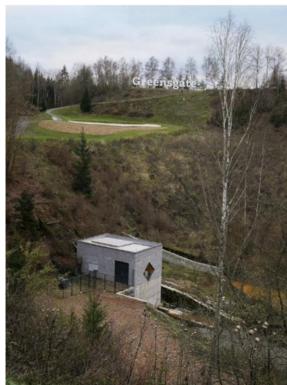
Malá vodní elektrárna u výtoku z pravého tunelu
