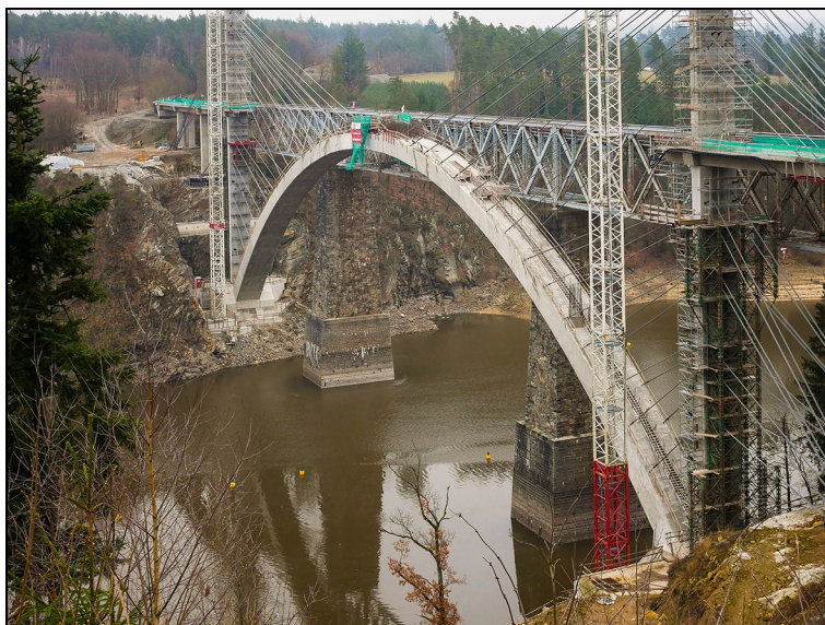
Jak se staví nový most (Červená n. Vltavou, foto JG 31. 12. 2023)
